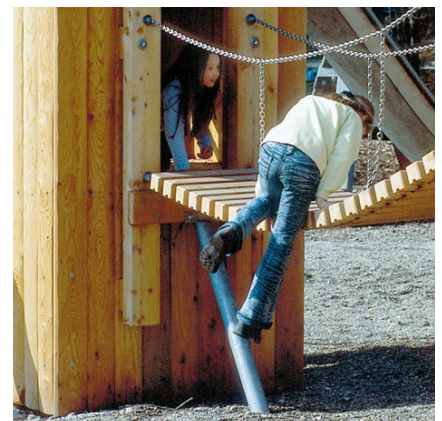
3.66090 hangbrug (stalen schoorpalen 3.66075)
