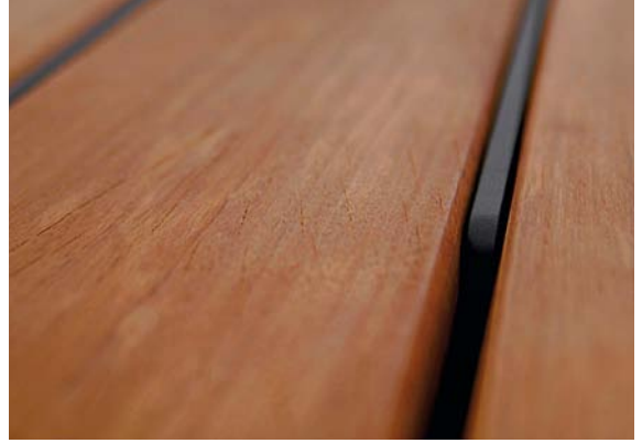
De massieve houten balken worden door even massieve staalribben op gelijke afstand van elkaar gehouden.
